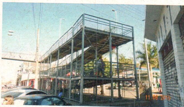
Foto 3 – Passarela metálica provisória.
