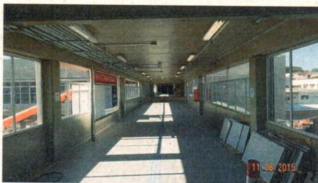
Foto 9 – Corredor de acesso ao mezanino da estação.
