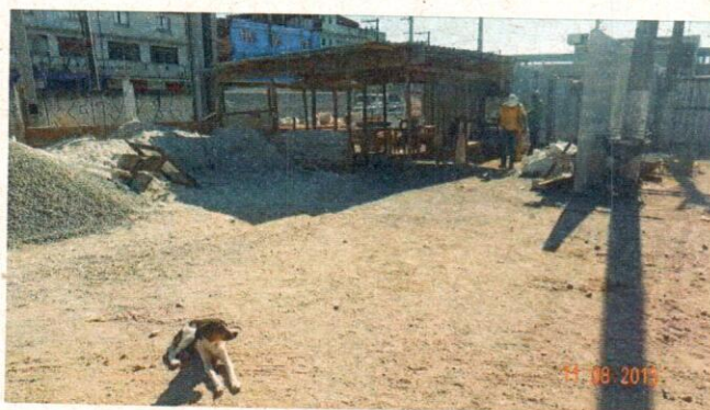
Foto 31 – Armazenamento de materiais e carpintaria.
