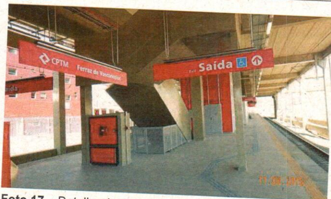
Foto 17 – Detalhe do piso tátil.
