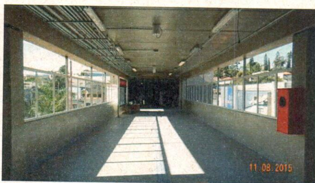
Foto 25 – Corredor de interligação do acesso sul.
