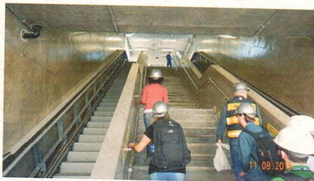
Foto 6 – Escadas rolantes e fixa do acesso norte.
