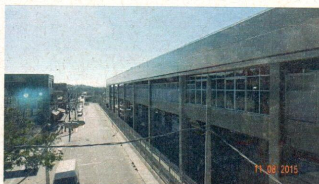
Foto 10 – Vista da Fachada da estação e Rua Godofredo Osório Novais, no sentido estação Estudantes.
